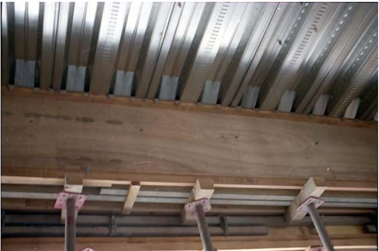
写真 3.梁型枠と合成スラブ用デッキプレートとの取り合い
