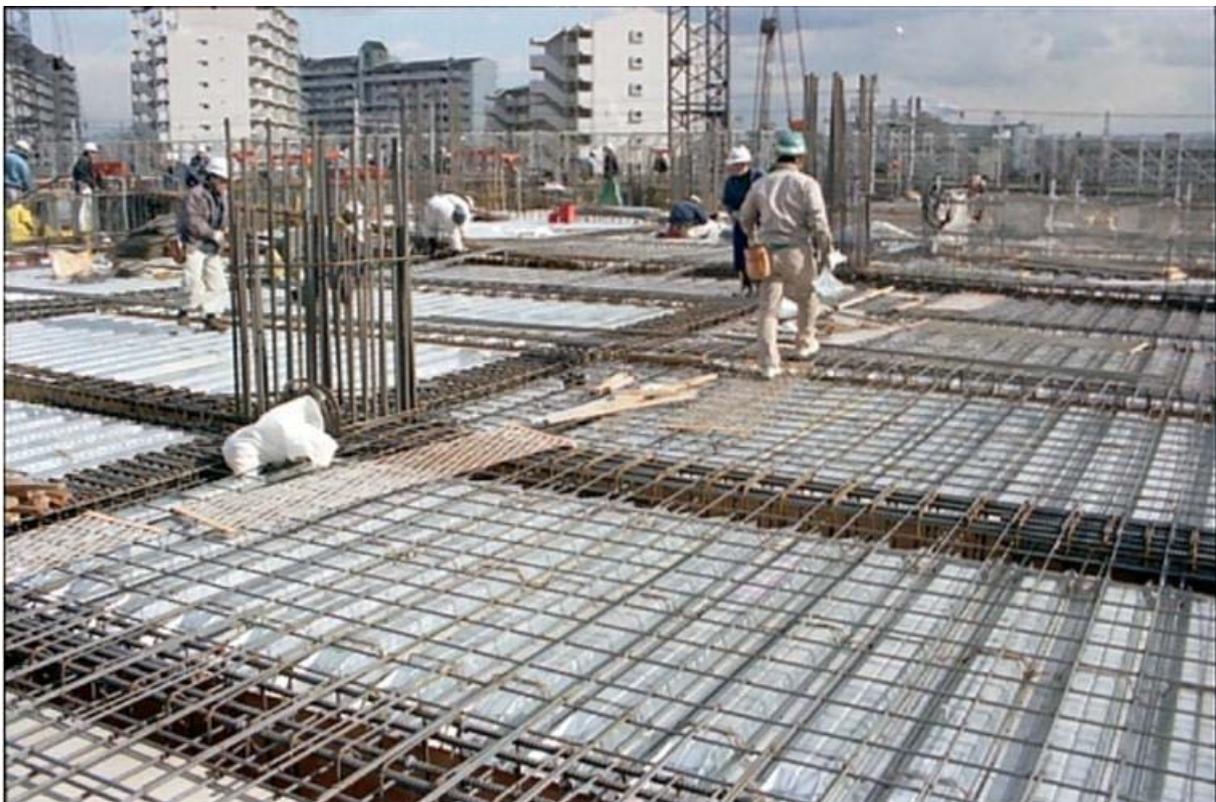
写真 1.デッキ合成スラブの配筋状況
