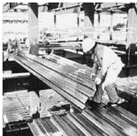
敷込み・仮止め
