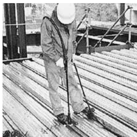
自動焼抜き栓溶接〔APW〕
