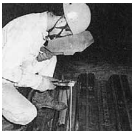
焼抜き栓溶接〔SPW〕
